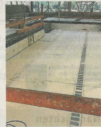
Der neue Hubboden wird derzeit eingebaut. DZ-Foto: privat
