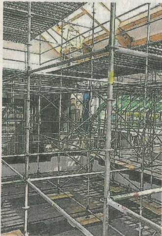
Noch ist die Schwimmhalle mit Baugerüsten ausgefüllt.
